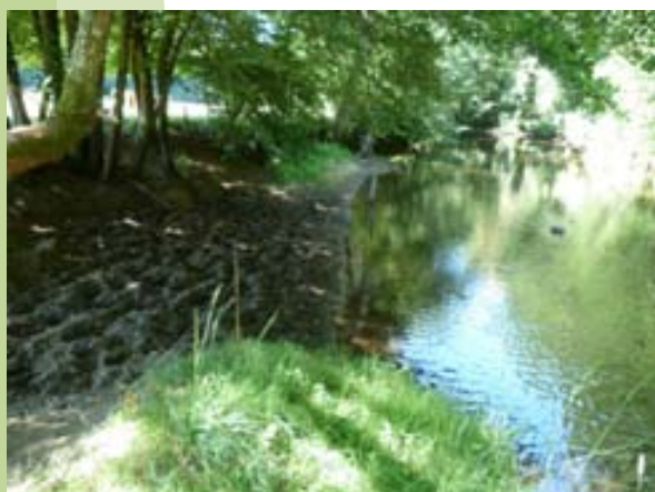
Figure 40 : Berge endommagée par le bétail
