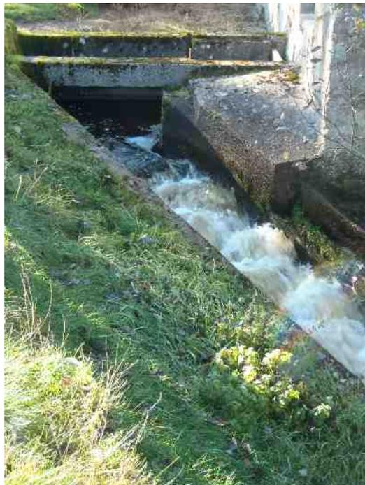
Il est prévu de poser des moines sur l'organe de vidange de l'étang pour contourner la passe à poisson non fonctionnelle et permettre le passage des truites. Le propriétaire souhaite garder la passe (droit d'eau).
