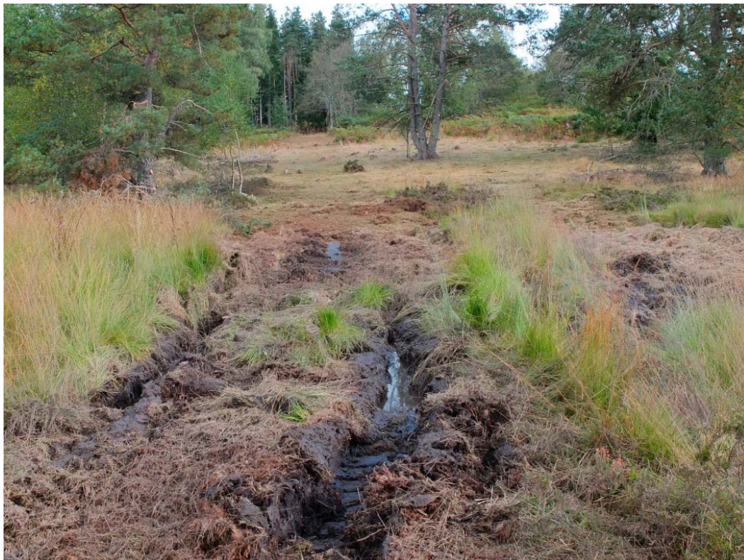
Réalisation de l'emprise à la mini pelle
