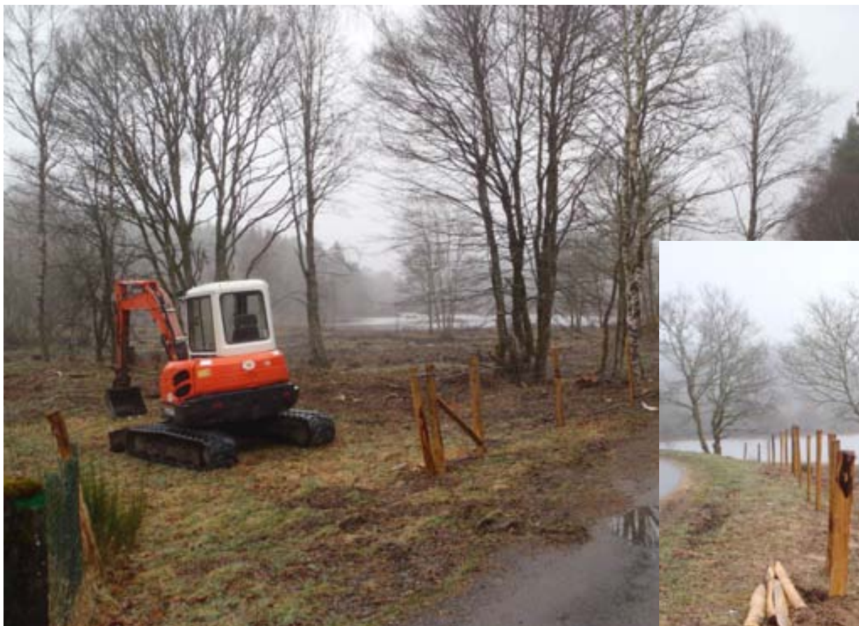
Pose de la clôture fixe (Marc POULET)
